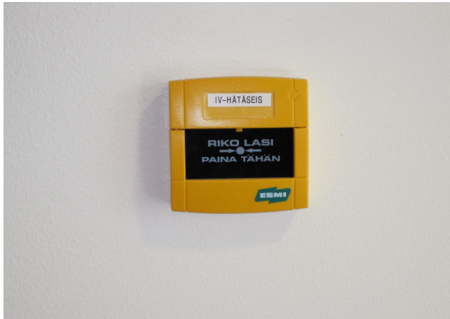
Kuva 3 (Ilmanvaihtolaitteiston hätäpysäytysnappi)
